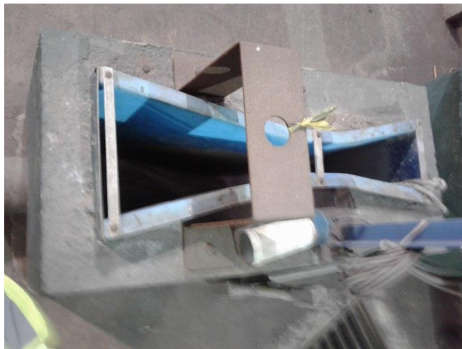
Figura 15 - Calha Parshall
