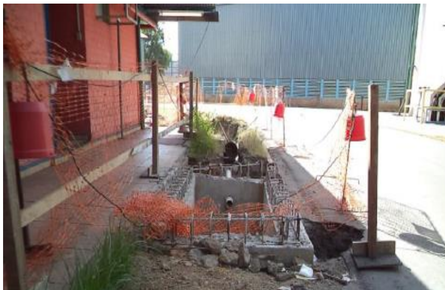
Figura 22 -Construção da caixa de gordura do restaurante
